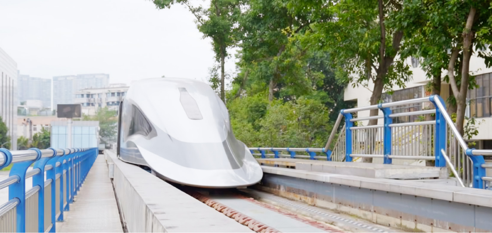
世界首条高温超导高速磁悬浮工程化样车及试验线
