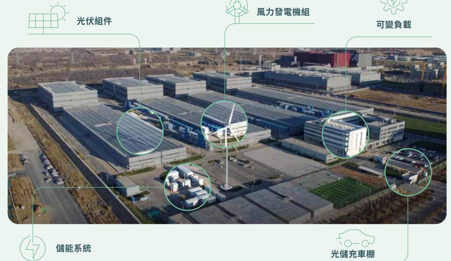
我們的數據中心「風光儲」一體化微電網項目於2024年11月正式併網發電。儲能以及負荷調節技術的應用能夠有效應對用能需求的峰谷變化，在緩解電網高峰時期供電壓力的同時提升數據中心的綠色電力使用比例。此外，我們利用數字技術實時監控和預測項目的可再生能源發電量，並通過優化運行模式進一步提升綠色電力的使用效率。
